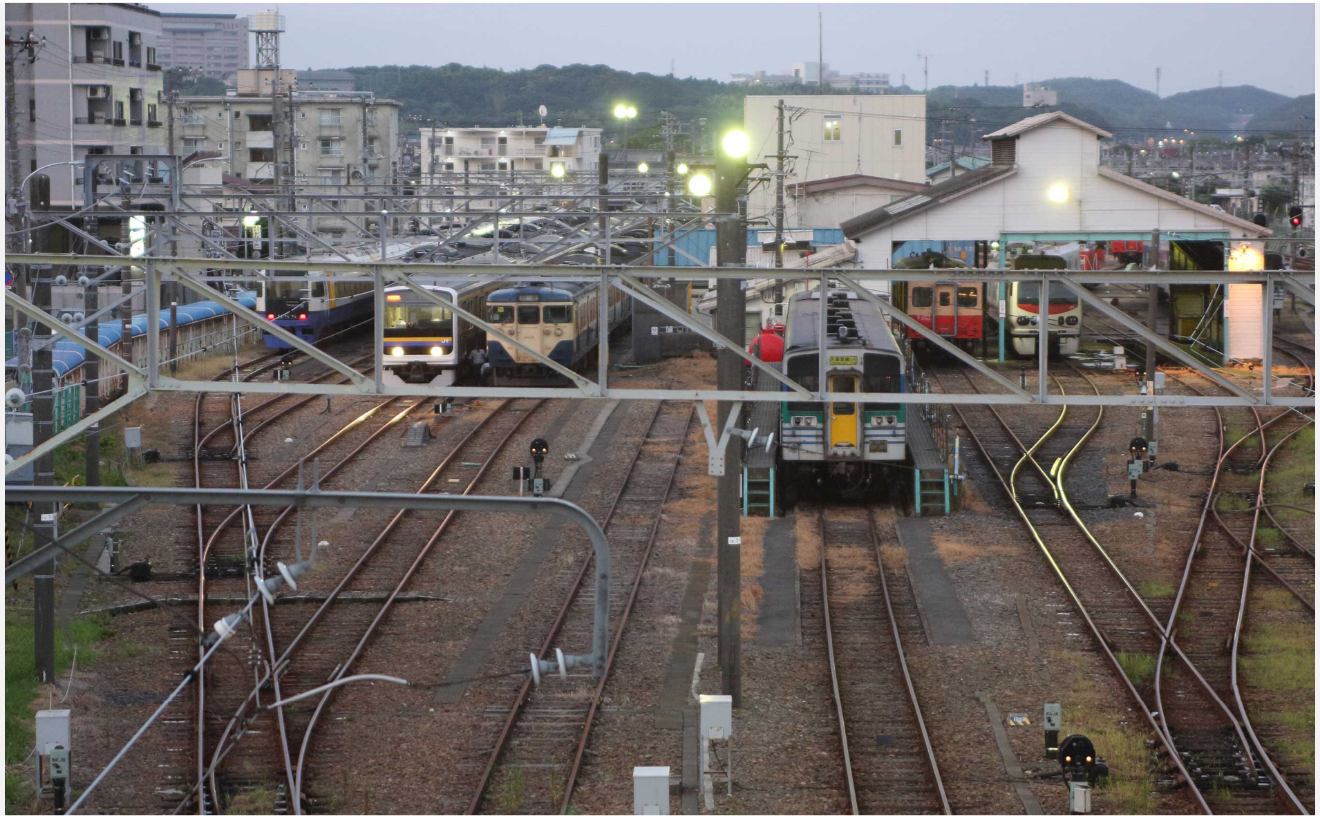
内房線木更津駅構内 2010年8月
