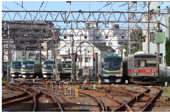
東急池上線車両基地 @雪が谷大塚駅そば
